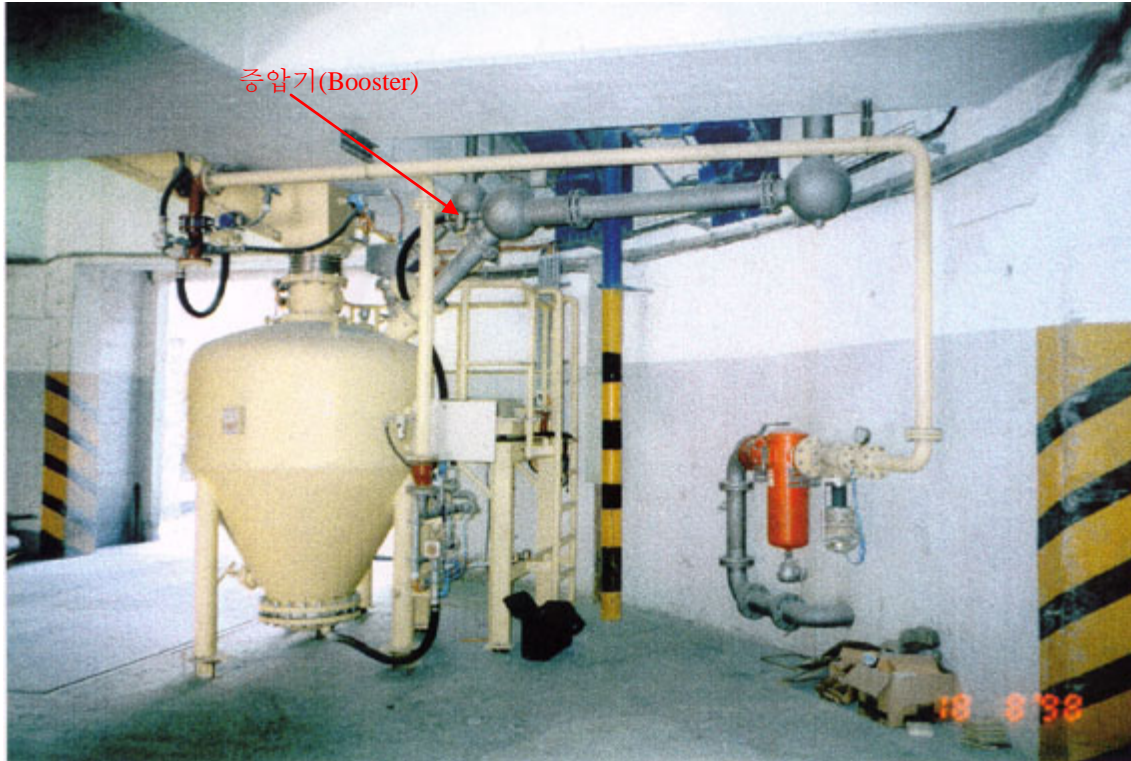
[그림 7] PVC 공장의 低密度狀 가압공기 이송설비에 적용된 SPECIAL ELBOW " Pneucon's Ball " 와 증압기(booster)
